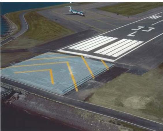
ZODIAC 社が1990年半ばに初めて EMAS を開発しました。実際の航空機を用いて約 55kts で進入し、航空機の損傷や乗客への影響などの実験を行い、設計・製造されました。過去に10回を超える航空機捕捉実績がある EMAS ですが、現在では ZODIAC 社は事業中止し、既存 EMAS の保守を目的に、フランスの会社がその一部を引き継いでいます。
