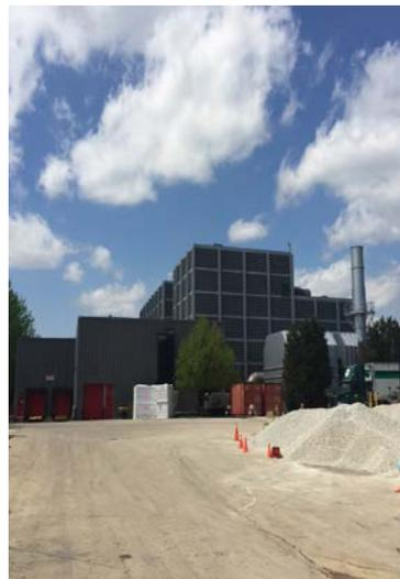
（写真上）大型火災試験室。昇降式の天井・消火施設が完備されており、内部に建築物を建設して室内で火災試験を行うことができる施設。その大きさは約 31m×約 37m と世界最大規模。
