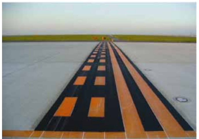
下地に黒を塗った状態(KIX B14 Taxiway)
