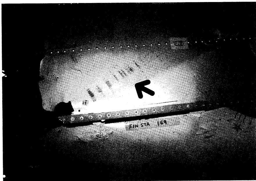
写真- 56 垂直尾翼フロント・スパー FS169付近のすり傷
